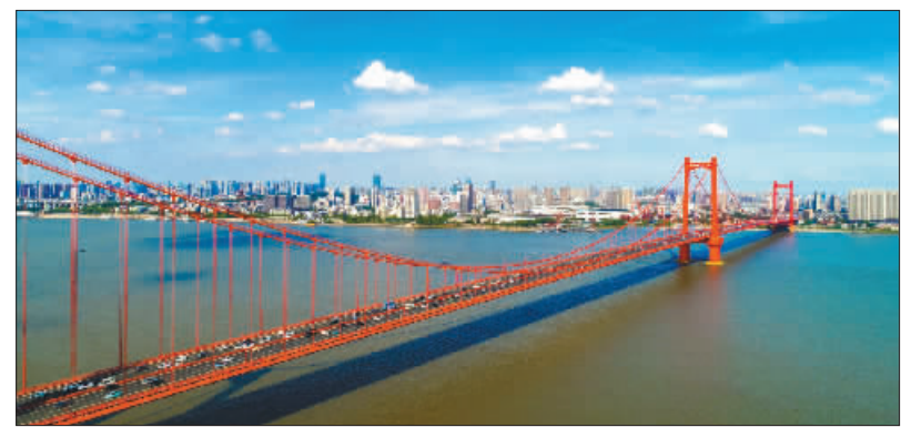
武汉鹦鹉洲长江大桥。
